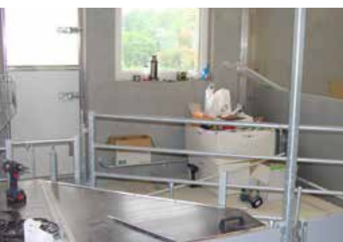
Im Abferkelbereich wird noch geschraubt..
